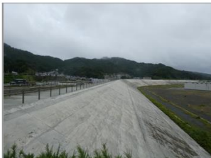
図1 大槌町の防潮堤（6.4メートル） 高さは震災前と同じで、町内から海を望むことができる。
